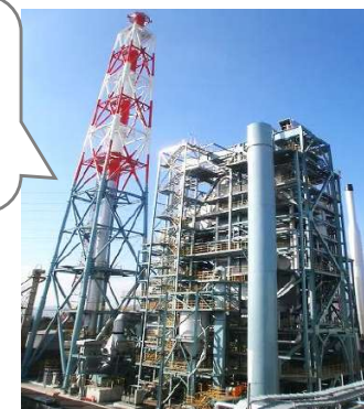
赤穂発電所外観
